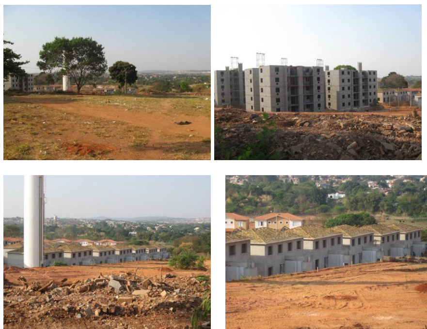
Figura 6 - Edifícios residenciais e condomínios horizontais ao lado dos escombros da "Vilinha" e nas margens do Rio Meia Ponte.
